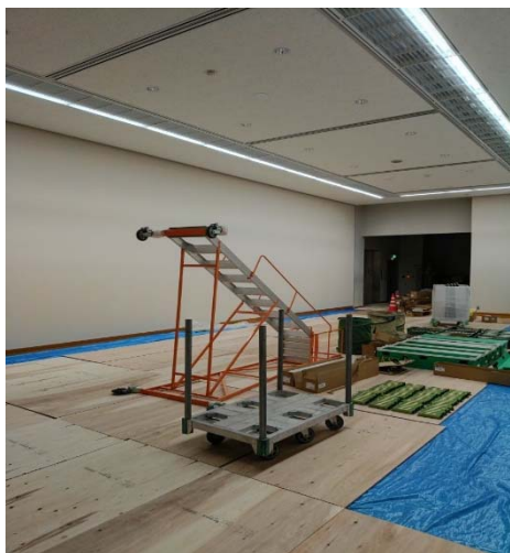
▲LED更新工事（2/1 現在） 美術センター作業状況
