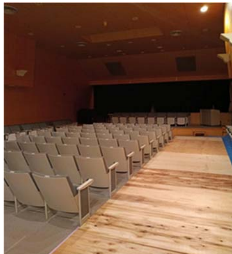
▲LED更新工事（2/1 現在） 講堂作業状況
