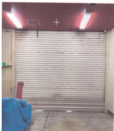
▲美術センター1階シャッター修繕
