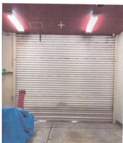
▲美術センター1階シャッター修繕
