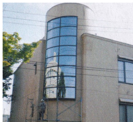
西地域図書館 雨漏り修繕
