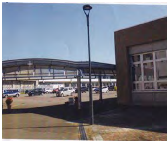
南地域図書館外灯修繕
