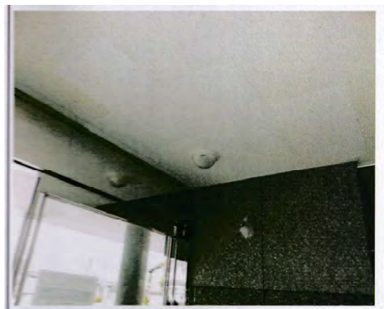
南地域図書館 雨漏り修繕
