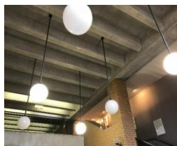
中央図書館 エントランス照明
