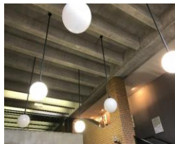
中央図書館 エントランス照明
