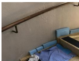
西地域図書館 雨漏り防止
