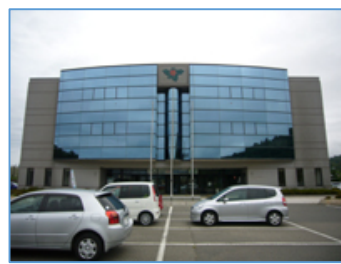
寺泊地域図書館 長岡市寺泊磯町 7411-14
