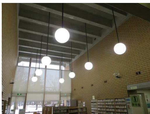
中央図書館 1階閲覧室照明
